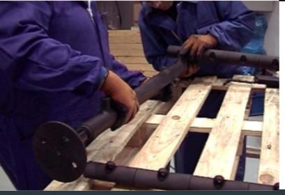
Unavez formados estos los atronillaremos a las columnas de los extremos. Es recomendable afinar el ajuste de la altura de las columnas mediante la regulación de la base.
